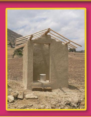
Al terminar la colocación del techo ya puedes poner la losa y la taza. Finalmente coloca una puerta pequeña que permita ventilar la letrina. Recuerda:
