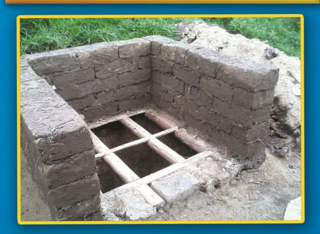
4.- Levanta las paredes de la letrina con una altura máxima de 2 metros. El interior de la caseta será de 1.20 m  $\times$  1.20 m. para que sea espaciosa y cómoda.
